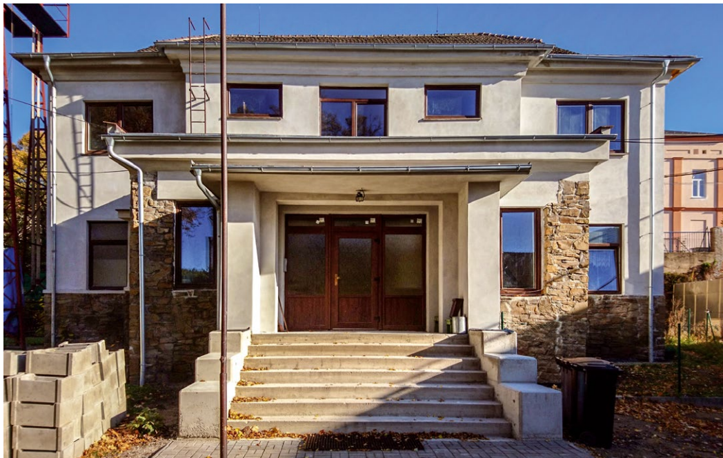
Opravený vstupní portál sokolovny
