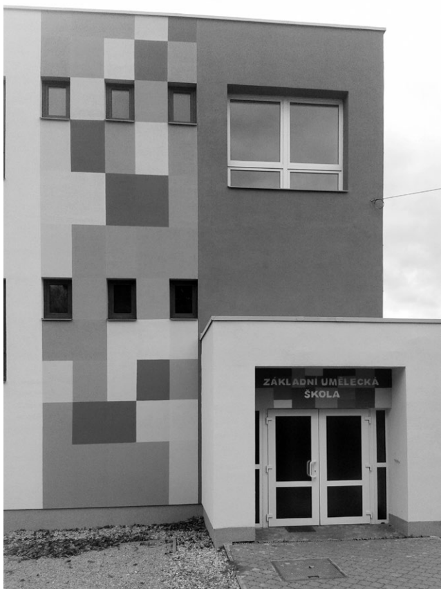
Budova ZUŠ – v novém (detail části s hlavním vchodem)
