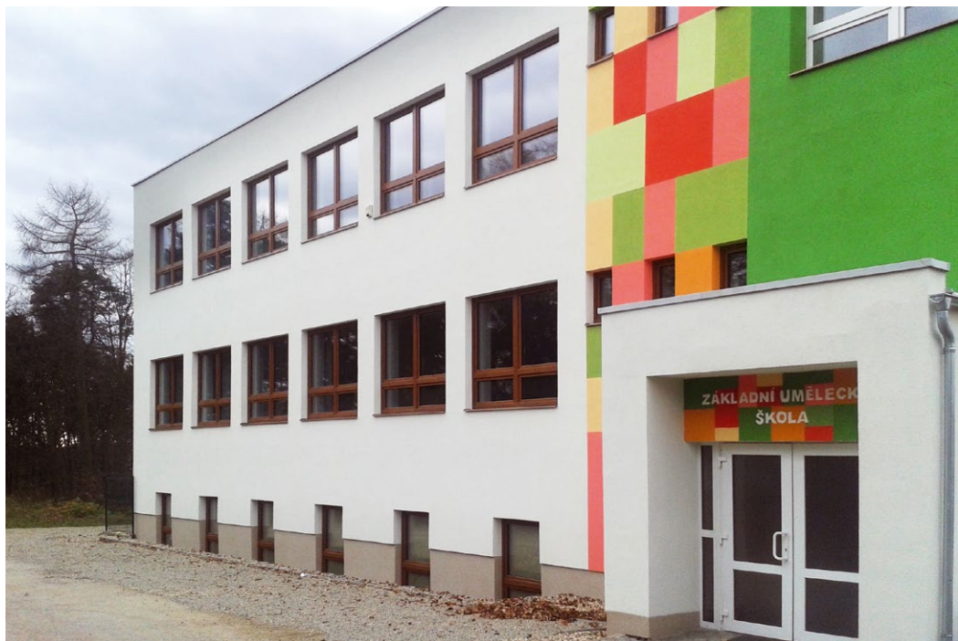
Budova ZUŠ – v novém (pohled na východní stranu s hlavním vchodem)
