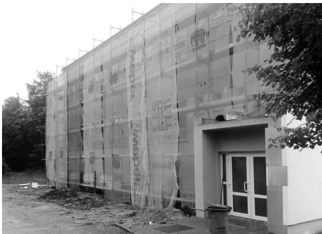
Budova ZUŠ – v rekonstrukci...
