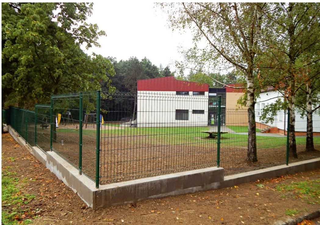
Rekonstrukce v obci
