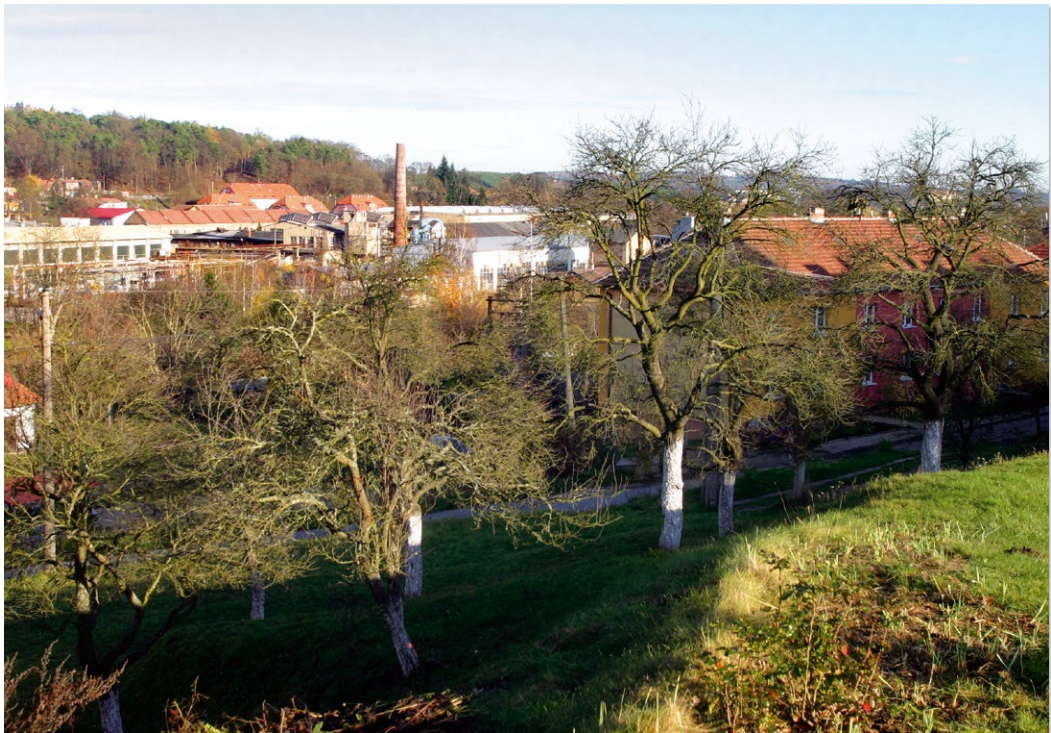
Pohled z Havířské směrem k bývalému dolu Julius (1930)
