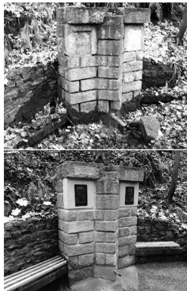
Studánka před rekonstrukcí a po ní
