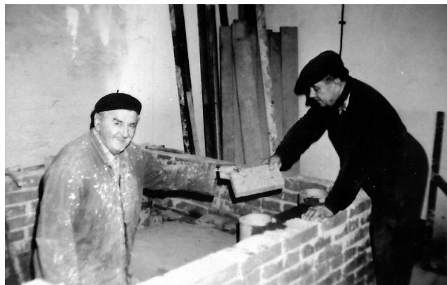
Výstavba sušící pece
